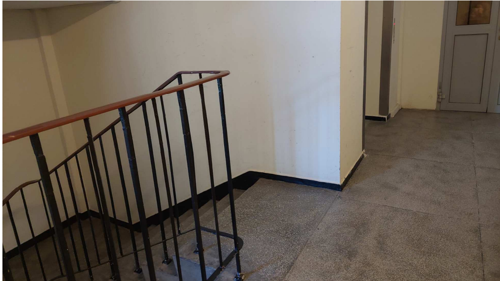
Rys. 11. Miejsce mocowania ruchomej barierki przy zejściu do piwnicy
