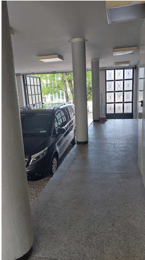
Fot. 8. Widok na rampę od strony południowej
