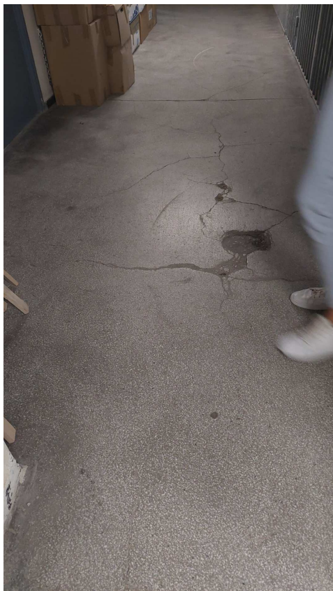
Fot. 4, 5. Nawierzchnia lastryka w korytarzu wyjściowym, widoczne uszkodzenia, spękania i ubytki lastryka
